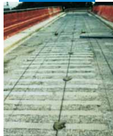
Láminas de Carboplate cubiertas con Mapegrout BM para rellenar los huecos
