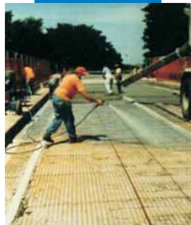
Aplicación de la imprimación epoxídica
