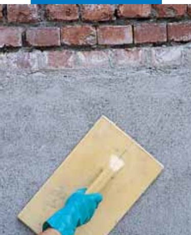
Acabado fratasado del revoco de Mape-Antique MC
