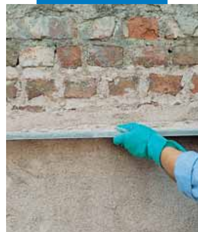
Nivelado del revoco de Mape-Antique MC con regle
