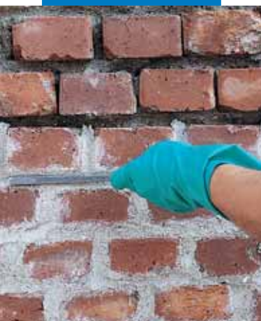
Relleno del llagado de los ladrillos
