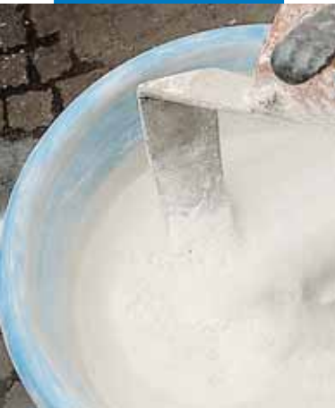
Preparación de la mezcla de Mape-Antique MC
