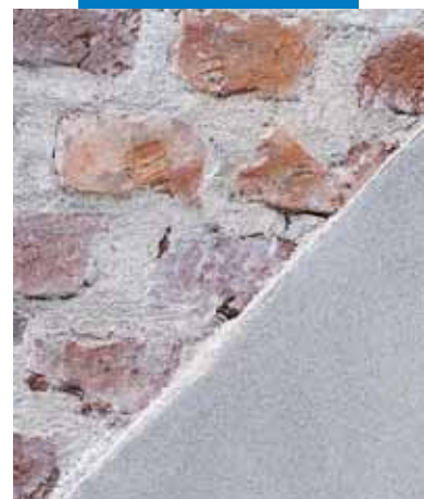
Detalle del relleno de juntas y del revoco realizados con Mape-Antique MC
