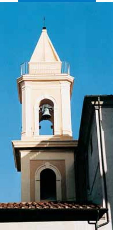
Campanario restaurado con Mape-Antique MC
