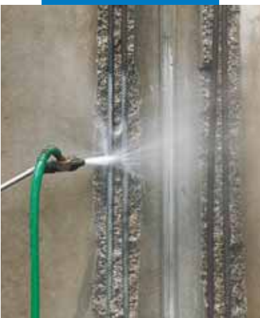
Limpieza de las armaduras con chorro de agua y arena
