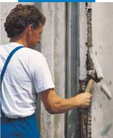
Demolición del hormigón degradado
