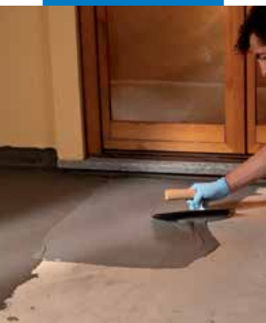
Impermeabilización de terraza a espátula
