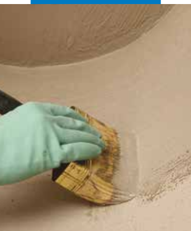
Impermeabilización de detalle a cepillo
