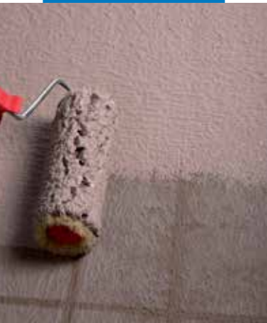
Impermeabilización de terraza con rodillo
