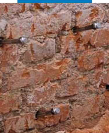
Detalle de los inyectores
