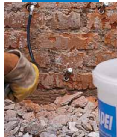
Inyección de Mapestop a baja presión
